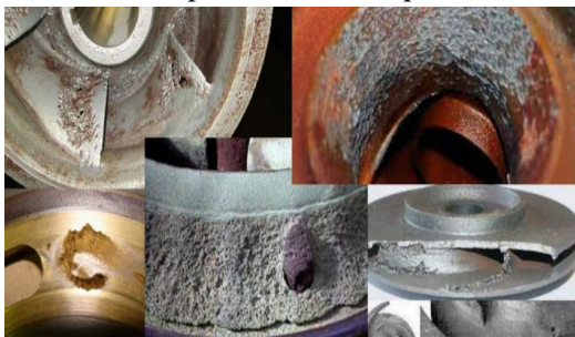
Gráfico 7. Impulsor con daño por cavitación.
