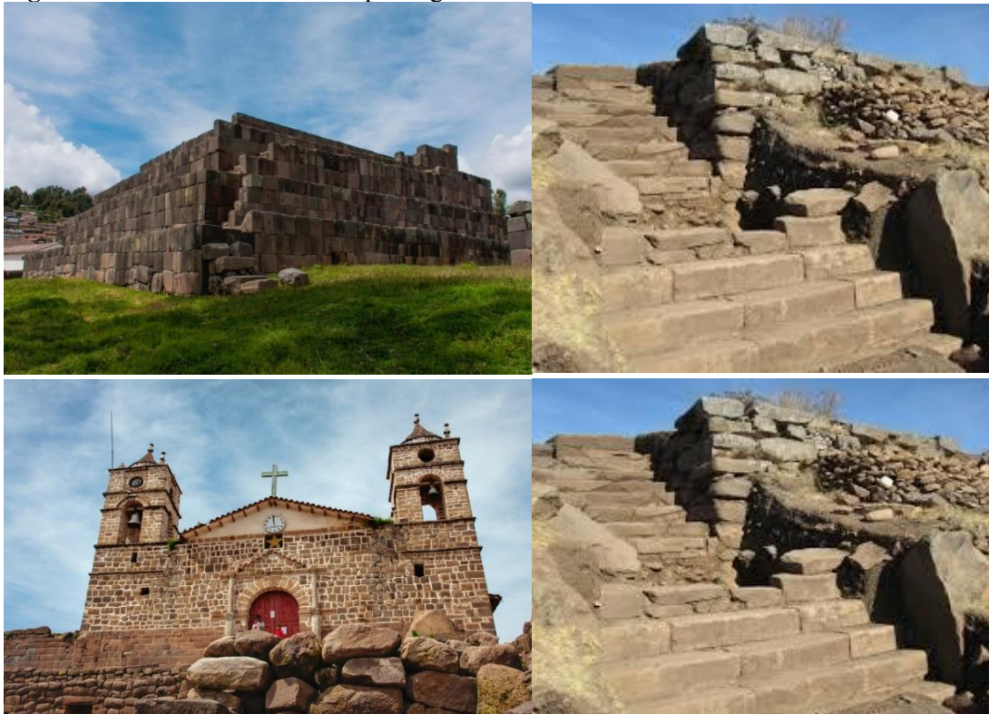
Figura 2: Deterioro del centro arqueológico de Vilcashuamán
