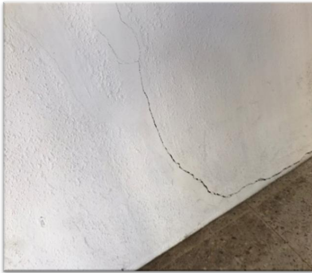
a) Muro de mampostería
