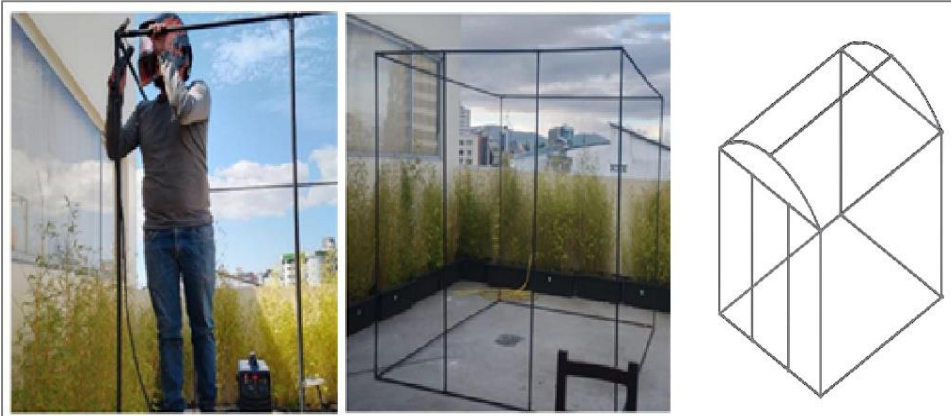
Figura 1. Implementación de la estructura del invernadero. (Mantilla et al, 2024, Moreno, 2024).
