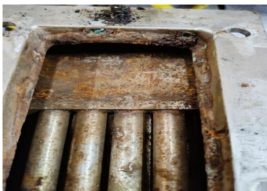
Figura 6. corrosión en tubos
